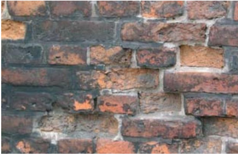
Rys: Mechanizm powstawania uszkodzeń mrozowych zawilgoconych elementów konstrukcji murowych o kapilarnoporowatej strukturze, Partyka J., Przegląd Budowlany 3 / 2015
