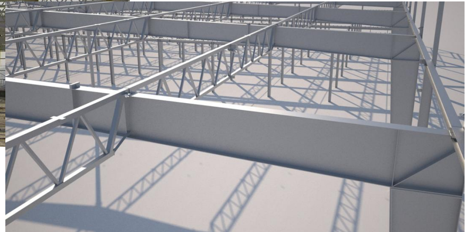
Photo: CoBouw Polska Sp. z o. o.
