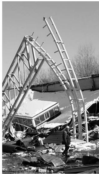
Photo: Z. Mendera, Analiza przyczyn katastrofy hali wystawowej w Katowicach, Awarie Budowlane 2007
