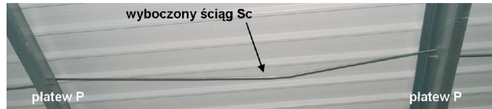
Photo: A. Biegus, Przyczyny przedawaryjnego stanu technicznego płatwi hali stalowej, Budownictwo i Architektura 12 / 2013, 173-180
